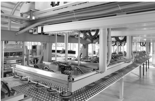
Saugplatten montiert mit Flexolink zur Handhabung von Riffelblech
